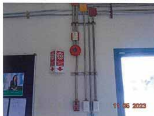
ภาพที่ 2-57 สัญญาณแจ้งเตือนเหตุเพลิงไหม้ (Fire Alarm)
