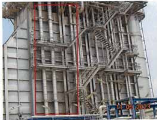
ภาพที่ 2-30 ฉนวนป้องกันความร้อน (Insulation)
