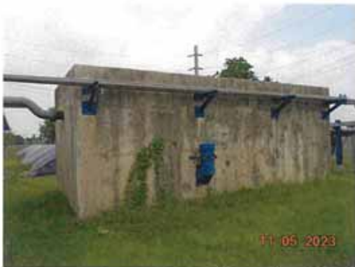
ภาพที่ 2-15 บ่อแยกน้ำและน้ำมัน
