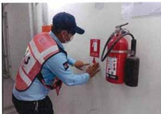
ภาพที่ 2-53 การตรวจสอบอุปกรณ์ดับเพลิง
