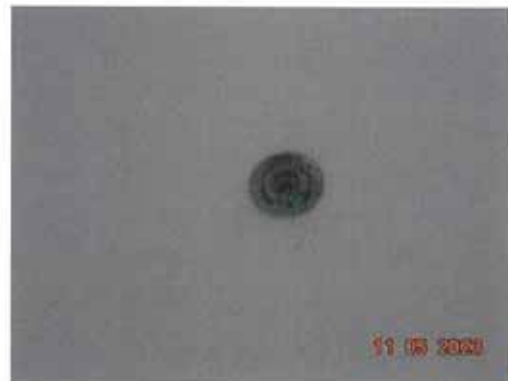
ภาพที่ 2-55 อุปกรณ์ตรวจจับความร้อน (Heat Detector)
