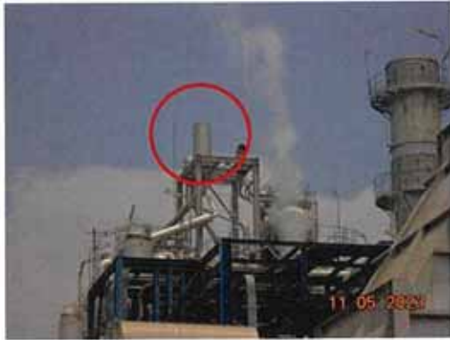
ภาพที่ 2-7 Silencer ที่ Safety Valve
