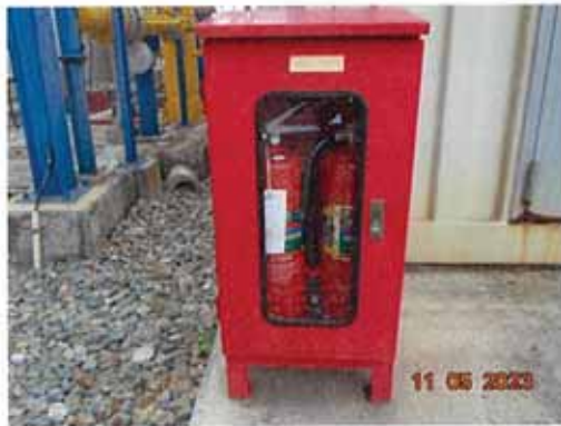
ถังดับเพลิงแบบมือถือ ชนิดผงเคมีแห้ง
