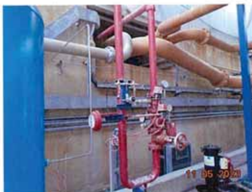
ภาพที่ 2-63 Fire Water Spray System บริเวณ Steam Turbine Generator Bearing Area
